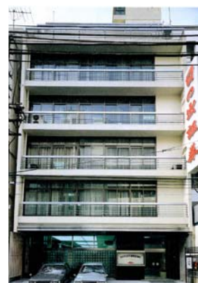
旧日の出証券本社 昭和38年完成
